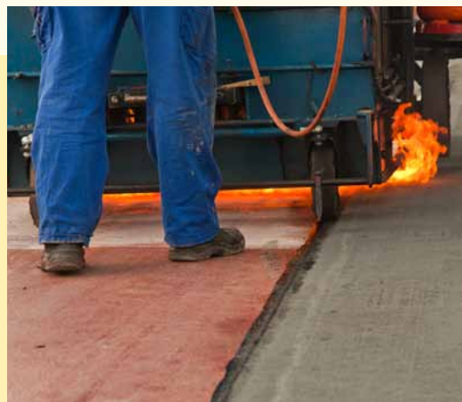
Pokládka BÖRNER OK 50 N
