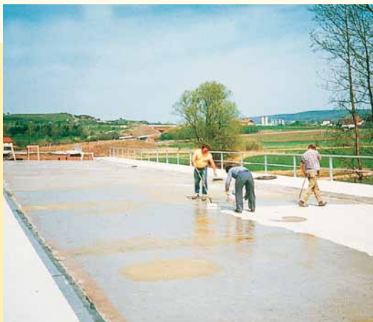
Pečetící vrstva z epoxidové pryskyřice
