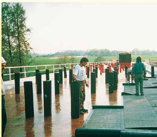
Příprava asfaltových pásů pro navařování
