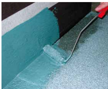
První nátěr BÖCOPUREM 1K po předchozí penetraci
