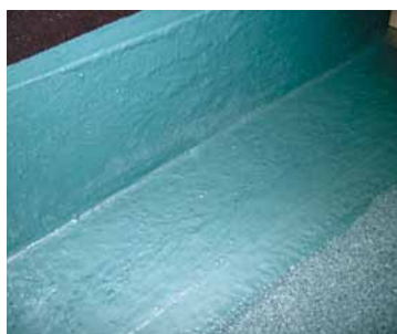
Hotová izolace atiky
